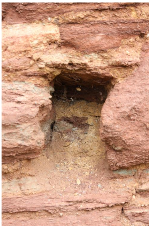
Obrázek 2: Detail místa odběru vzorku zdicí malty, foto zadavatel
